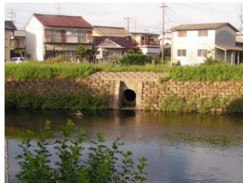
写真-2-④ 高田西 3号排水路
