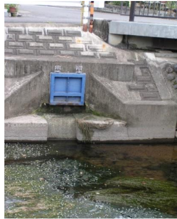
写真-2-② 高田東排水路フラップゲート
