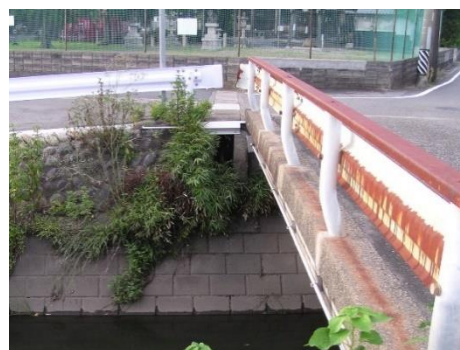
写真-2-⑥ 道路側溝・下流側
