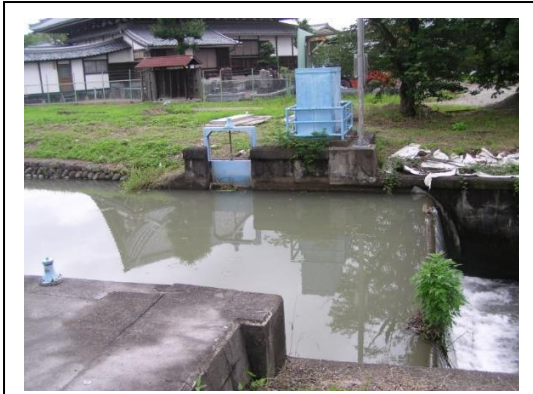
写真-2-1 山後用水路取水口(境川右岸 ら、南東奥は正巖寺 2020年6月)
